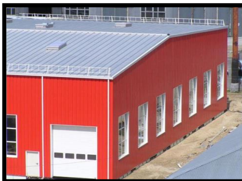
Строительство промышленного парка ООО «Астрон»
