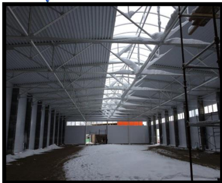
Строительство молочного комбината на переработку 150 тонн молока в сутки
