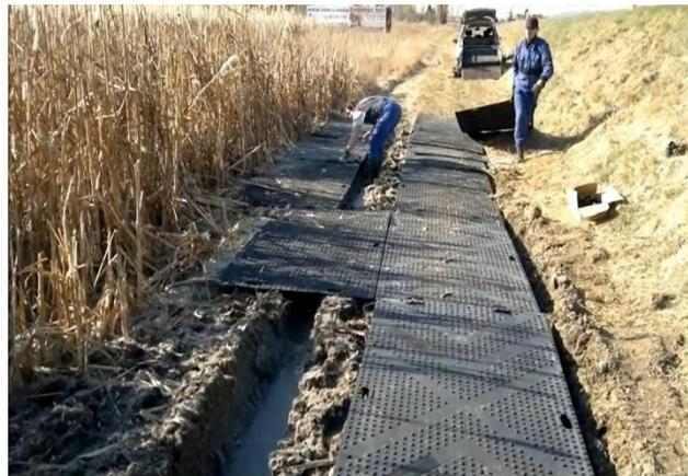
Сооружение технологического проезда и площадки на обводненном участке со слабонесущем верхним слоем
