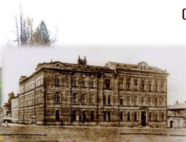
Здание мужской гимназии - памятник архитектуры областного значения
