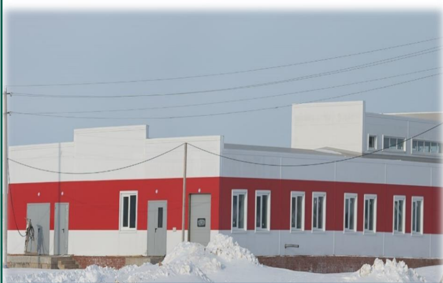
Строительство цеха по убою и переработке скота
